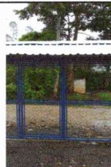
Foto 6: Mantenimiento de Portón
