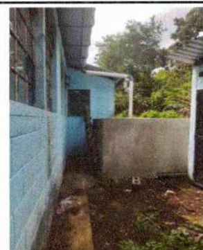
Foto 4: Mantenimiento de Cisterna
