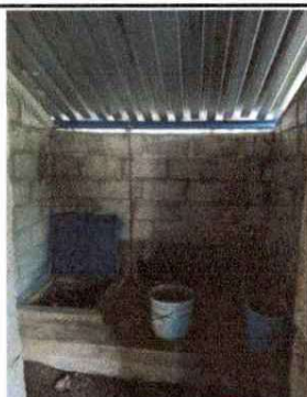
Foto 3: Mantenimiento de Cisterna
