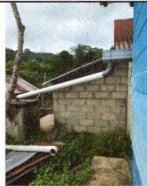
Foto 4: Canales y Bajadas de agua pluvial
