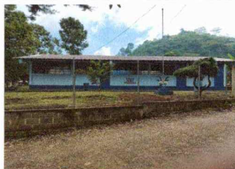
Foto 6: Aplicación de Pintura
