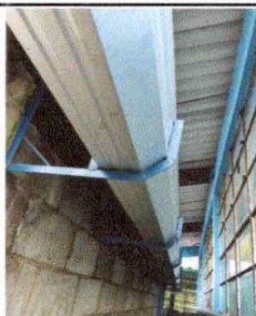
Foto 5: Canales y Bajadas de Agua Pluvial
