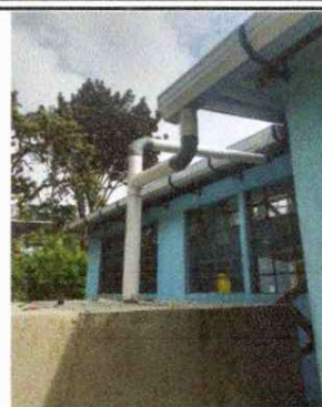
Foto 2: Canales y Bajadas de agua pluvial
