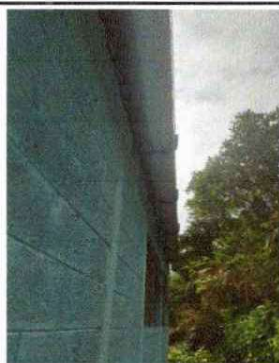
Foto 3: Canales y Bajadas de agua pluvial
