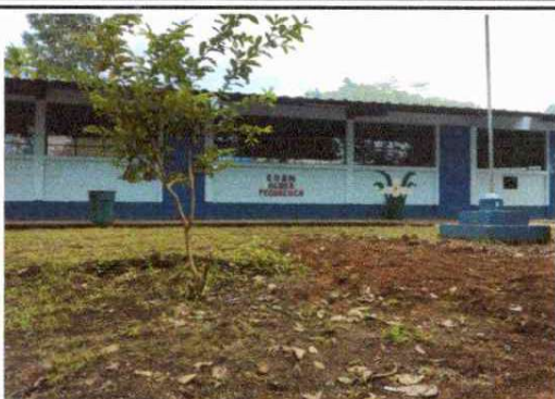
Foto1: Mantenimiento de Puertas
